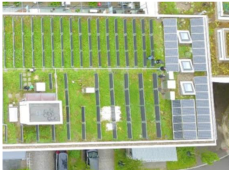
Abbildung 47: Luftaufnahme eines Teils der Mattenbach-Dachfläche. Rechts am Dachrand sind klassische Systeme mit flachem Kippwinkel, links vertikale PV-Systeme angeordnet. Durch die vertikalen Systeme wird der Gründach-Charakter trotz PV erhalten.
