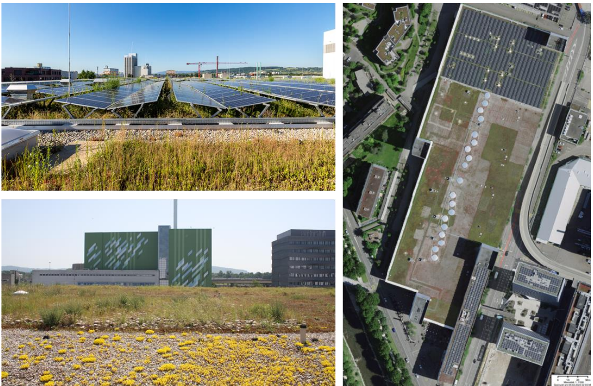
Abbildung 61: Untersuchungsfläche auf dem Einkaufszentrum Stückli in Basel mit Bereichen mit Kombinationen Dachbegrünungen und PV sowie ohne PV-Belegungen. Fotos: Andreas Hofstetter, Swisstopo
