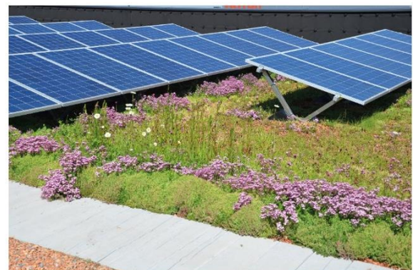
Abbildung 49: PV-System mit moderatem Kippwinkel und teilweiser PV-Belegung der Dachfläche mit Abstand zum Grund. Die verbleibende Fläche und auch die Fläche unter den Modulen kann begrünt werden. Bei ausreichendem Abstand und Höhe ist der begrünete Bereich für Wartungsarbeiten zugänglich.
