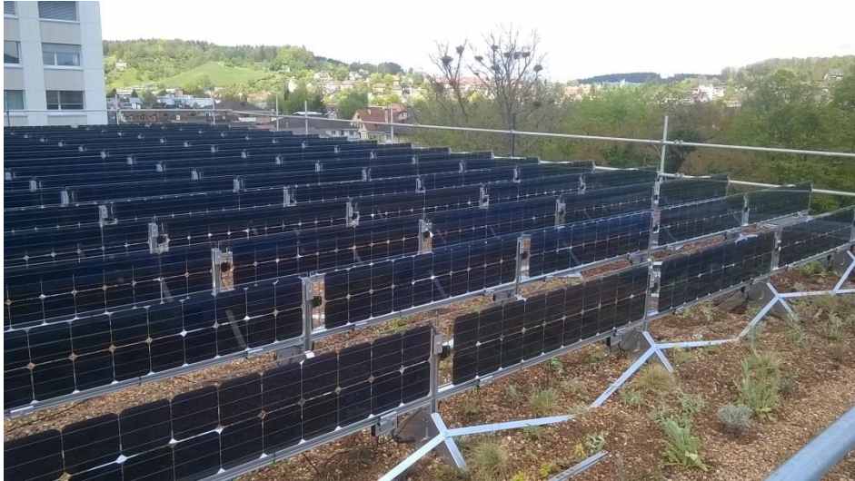
Abbildung 2: Vertikal montierte, bifaziale Lamine in Ost/West-Ausrichtung in schmaler, 20-zelliger Ausführung auf einem Gründach in Winterthur [11].
