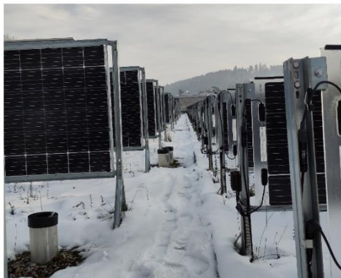
Abbildung 24: Die vertikalen Systeme (links) bleiben frei von Schnee, während die anderen Systeme erwartungsgemäss bedeckt sind und keinen Ertrag liefern.
