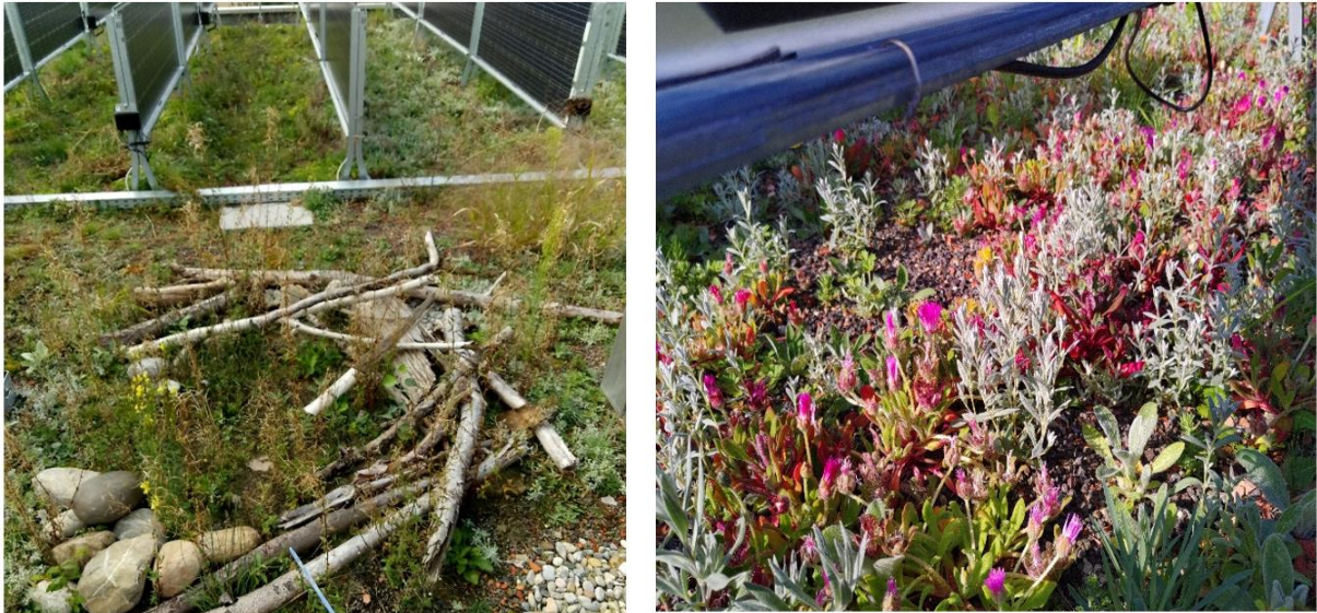
Abbildung 10: Totholzinsel zur Ansiedlung von Wildbienen und Detailaufnahme der Dachbegrünung mit niedrigwachsender Bepflanzung.
