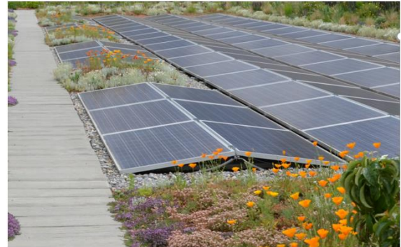
Abbildung 48: PV-System mit flachem Kippwinkel und teilweiser PV-Belegung der Dachfläche. Die verbleibende Fläche kann begrünt werden.
